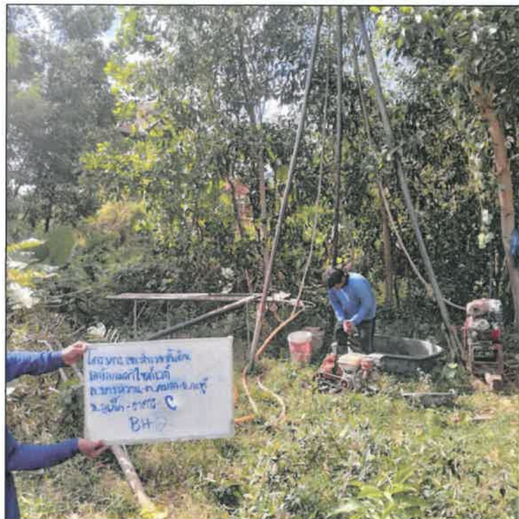
ภาพถ่ายขณะปฏิบัติงานเจาะสำรวจดิน BH-7 (อาคาร C)
