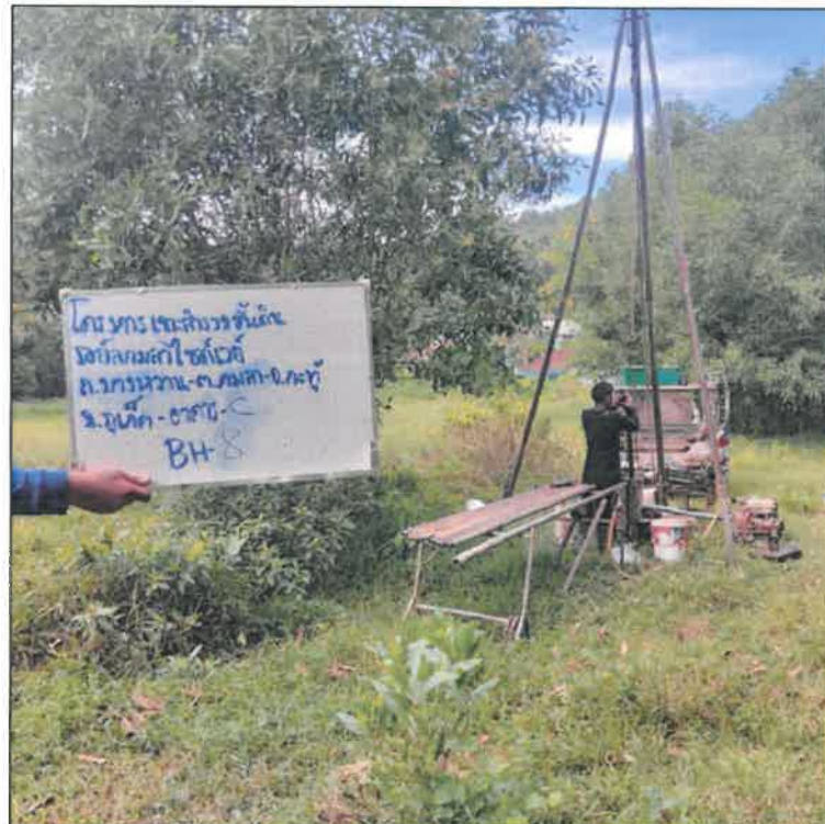
ภาพถ่ายขณะปฏิบัติงานเจาะสำรวจดิน BH-8 (อาคาร C)
